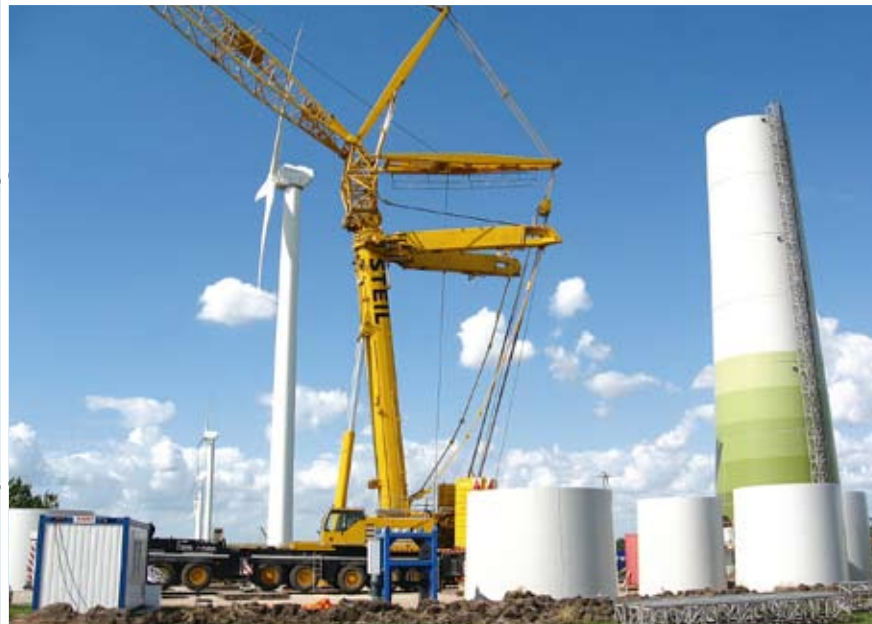
Repowering-Projekt Schobüll in Schleswig-Holstein: 2009 wurden sechs Tacke-Anlagen vom Typ TW600 durch vier Enercon-Turbinen E82 ersetzt. Fotos (2): Denker & Wulf
