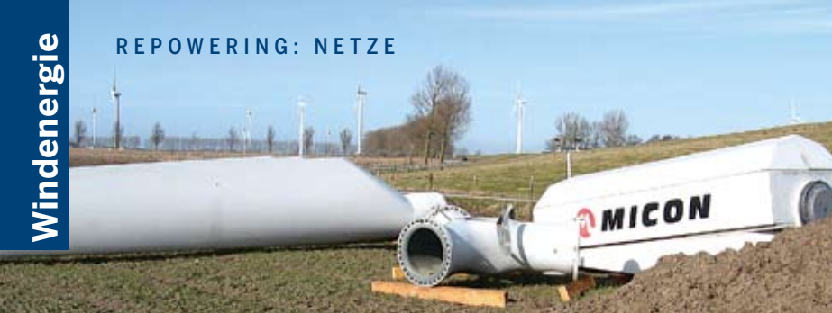
Abgebaute Micon-Anlagen im Windpark Friedrichskoog
